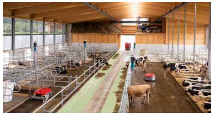
Automatisierung im Neubau
